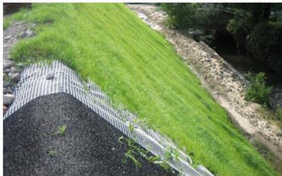
Рис. 7. Укрепление склона травянистой дернообразующей растительностью
