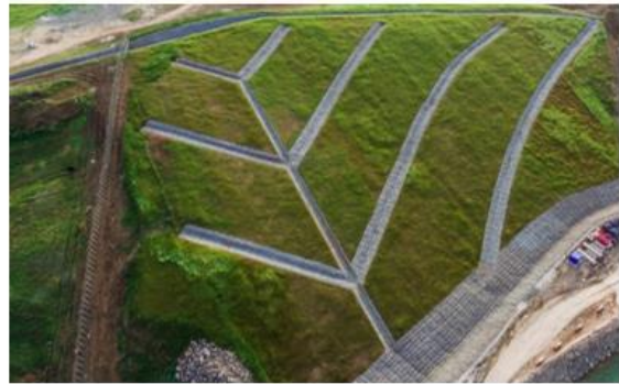
Рис. 8. Осушение оползневого склона
